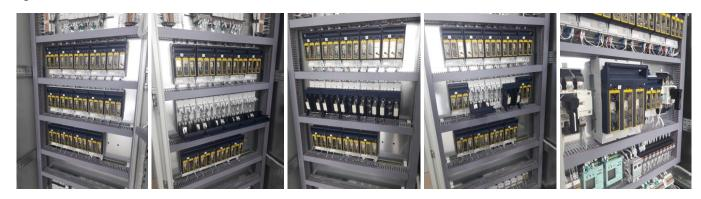
В качестве альтернативного решения на верхнем и среднем уровне применяются селективные автоматические выключатели, предназначенные для использования только в сетях постоянного тока отечественного производства серии ВА или автоматические выключатели зарубежных производства фирмы ETI серии EB2 совместно с выносным блоком защиты - РМПТ.
