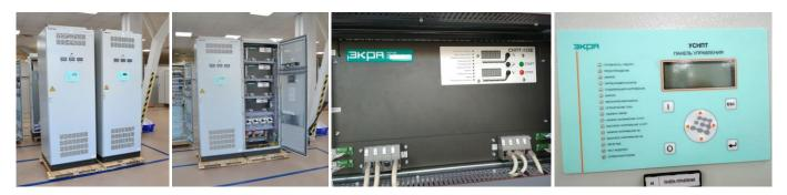
Связь с АСУТП по каналам связи: интерфейсы RS-485 или Ethernet, через GSM, оптоволокно. Имеется встроенный WEB-интерфейс.
